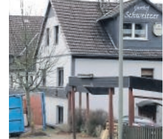
Der ehemalige Gasthof Schweitzer während der Sanierung. Die Stadt trennt sich von der Flüchtlingsunterkunft. FOTOS: VON DER BECK
